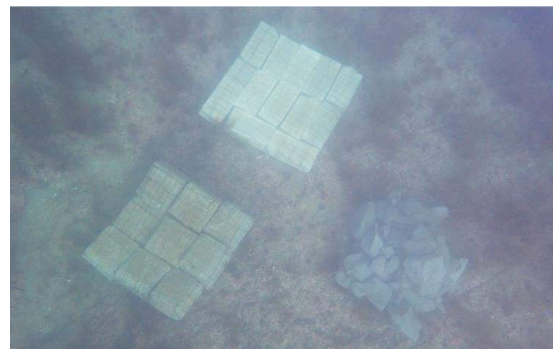
図-6 コンクリートブロック設置後
